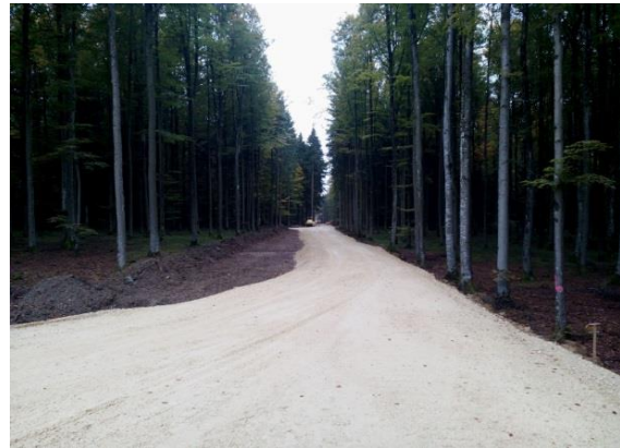
Ausbau des bestehenden Waldweges und Rodung einer weiteren Fläche für den Kranausleger (links im Bild). Das Foto wurde aus Blickrichtung der Kranstellfläche aufgenommen. (Foto: wpd)
